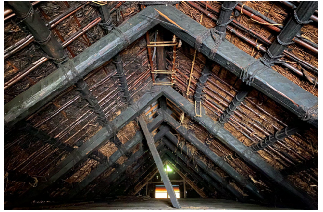
4階 屋根は茅が残っています
