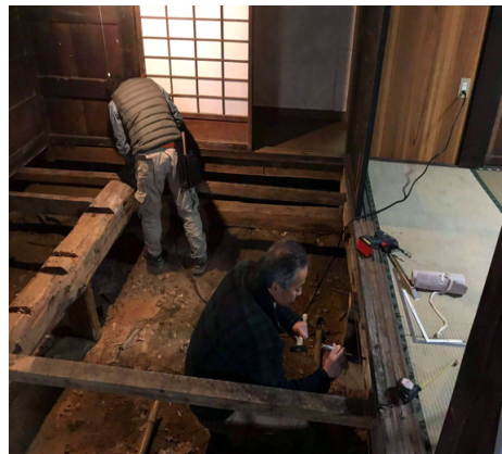
床のDIY改修
