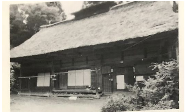
茅葺きの時代「山梨県の民家」より
